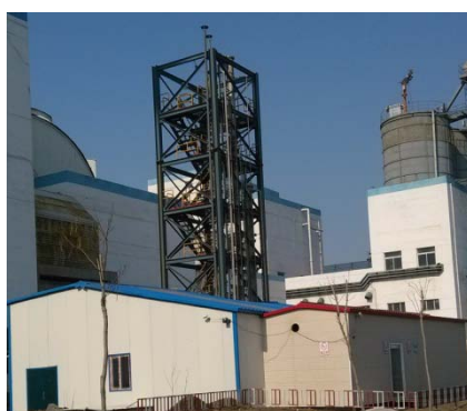
65 长春热电厂燃烧后 CO 2 捕集中试装置
