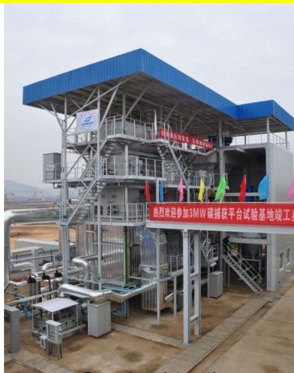
Oxyfuel boiler 锅炉岛
