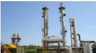
**中原炼厂烟道气捕集:** 以一乙醇胺为主溶剂的MEA法，捕集规模10万吨/年
