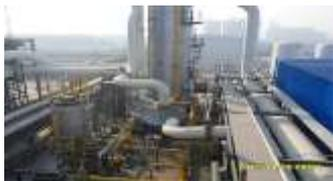
**胜利燃煤电厂烟气捕集:**以MEA为主、添加了活性胺、缓蚀剂、抗氧化剂等辅助成分的复合MSA溶剂，捕集规模3万吨/年
