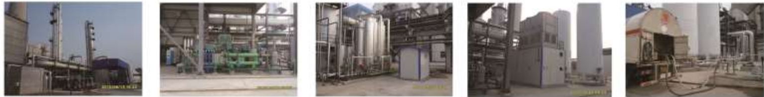
胜利电厂捕集纯化 → 压缩 → 干燥 → 液化 → 储存装车
