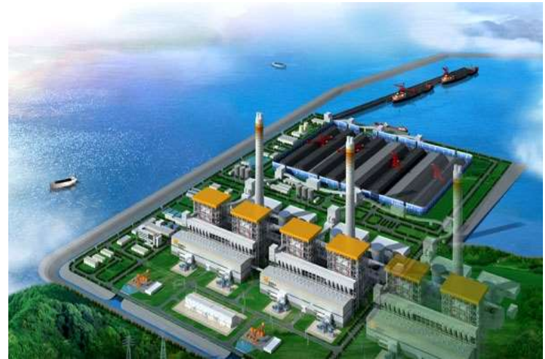
华润海丰100吨/天碳捕集测试平台
