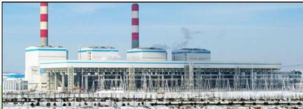
陕西国华锦界（4×600MW）煤电一体化项目
